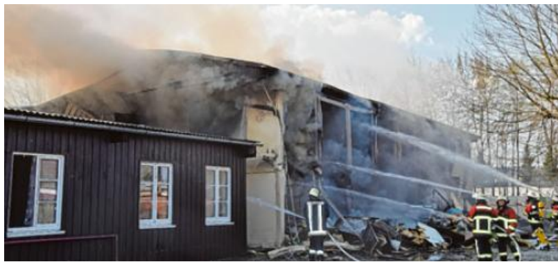
Feuerwehrmänner mussten am Dienstagnachmittag zum dritten Mal das Asylheim löschen. Glutnester hatten erneut die Schaumstoffdämmung in Brand gesetzt.
