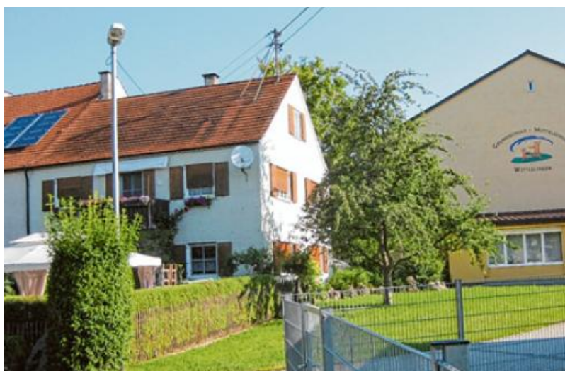
Der ehemalige Bauhof in Wittislingen liegt zentral in der Ortsmitte neben der Grundschule. Foto: Dieter Schleifer
